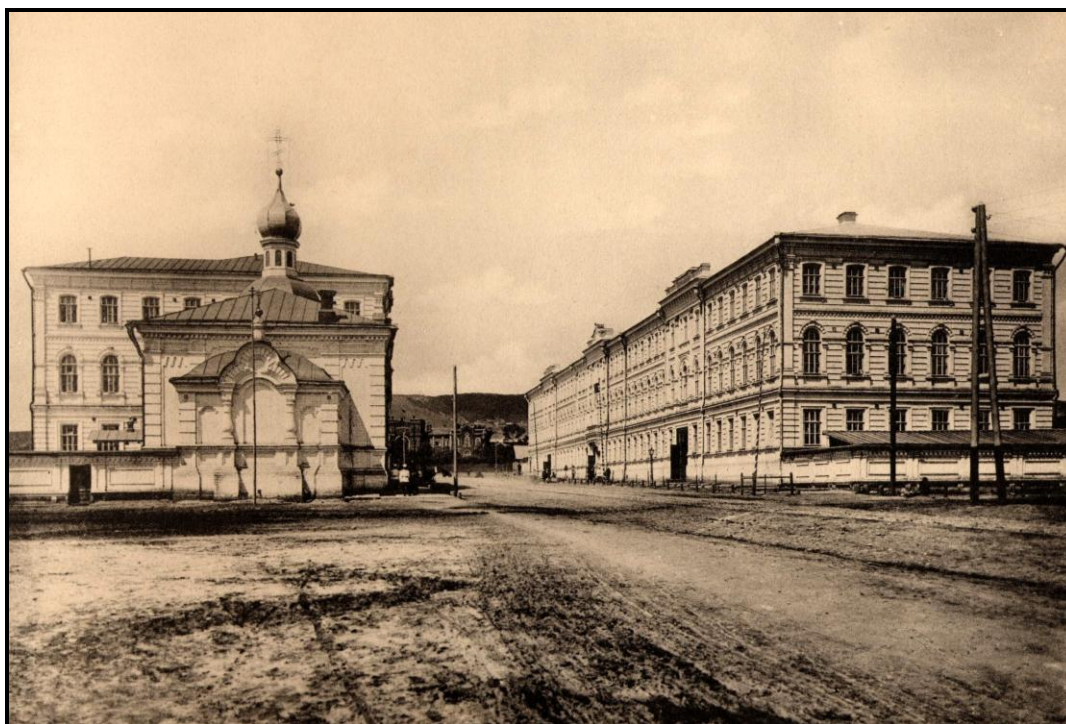
Новые городские казармы. 1905-1906 гг. Слева корпус казарм для Бобруйского, а справа для Балашовского резервных батальонов. На переднем плане бригадная церковь во имя Св. благоверного великого князя Александра Невского.
